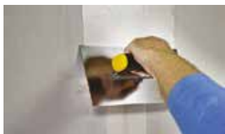
Az illesztést 30 cm szélességben simítsuk le.
