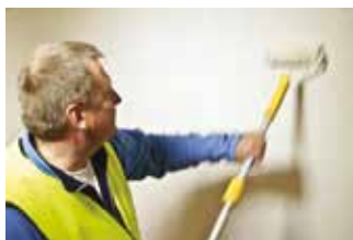
Teljes gipszkarton felületre legalább 1mm vastag simítás kerül.
